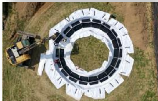
Leur mise en place
