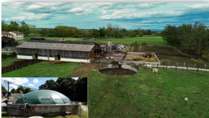
La bâche Nénufar installée sur la fosse à lisier © Alexis Picot
