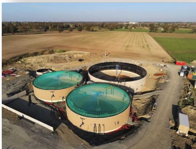
Chantier en cours sur l'unité de méthanisation Deligeard Biogaz © Seya
